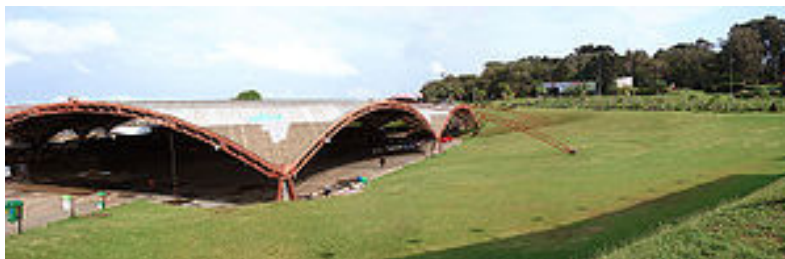
Vista parcial do Parque de Exposições Mário Bernardino Ramos (Pavilhões da Festa da Uva, em Caxias do Sul).
